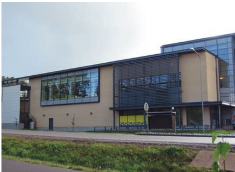
▲ Söderkulla bibliotek finns i andra våningen i fastigheten som ägs gemensamt av Varuboden och Sibbo stad. I biblioteket finns skilda arbetsrum för bibliotekarien och för den övriga personalen, sociala utrymmen, magasin, en stor aula och en härlig terrass. I samband med biblioteket finns också Sibbo konstnärsförenings artotek. Foto: Annette Broman.
