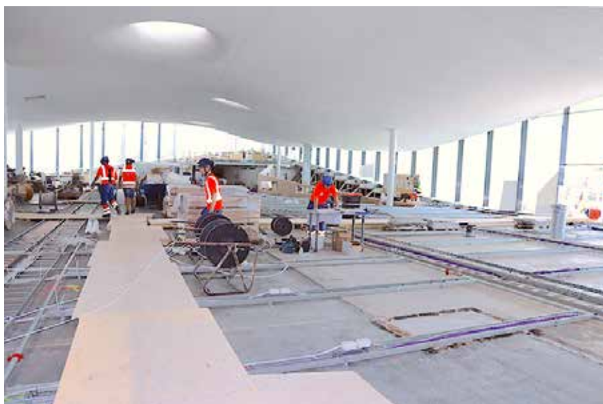
Elinstallationer i bokhimlen. Foton från byggarbetsplatsen: Liisa Joensuu
