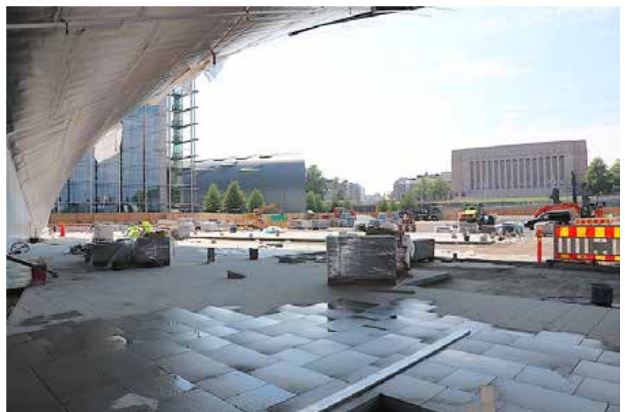
Stenläggning framför huvudingången.
